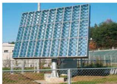
集光 2 軸追尾型 (3kW)
